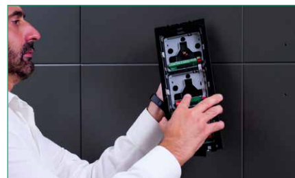
4. POSIZIONARE la pulsantiera a parete, far passare i fili dell'alimentazione nell'apposita sede e fissarla tramite le due viti, situate in alto e in basso
