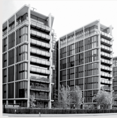
INSTALACIONES RESIDENCIALES MEDIANAS/GRANDES
