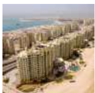
EAU, Dubai, Palm Jumeirah Edificio residencial de lujo en Palm Jumeirah Sistema Comelbus 1.323 monitores en color Videocom con sistema CCTV
