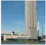
Holanda, Rotterdam, Torre New Orleans Uno de los más prestigiosos edificios de Rotterdam 240 monitores Planux
