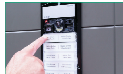
10. PRESIONAR el pulsador al que se asignará la dirección seleccionada en el punto anterior. La correcta asignación de la dirección se confirma mediante una señal acústica. SELECCIONANDO en secuencias los demás pulsadores, asumen automáticamente la dirección de llamada con el siguiente código
