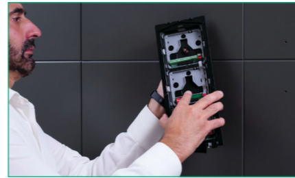
4. COLOCAR la placa de calle en la pared, pasar los cables de alimentación por el correspondiente alojamiento y fijarla con los dos tornillos, situados en la parte superior e inferior
